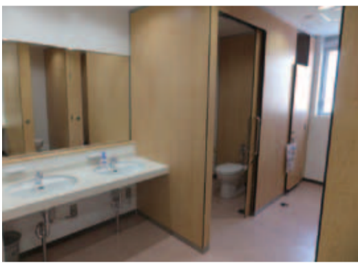
■改修工事を行った栄小学校のトイレ
