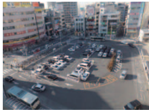
地下自転車駐車場の整備が予定されている志木駅南口駅前広場
