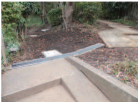
横断側溝等を設置し、雨水対策を図った栗原緑地公園
