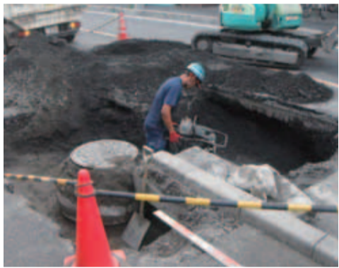
道路陥没があった現場の復旧工事の様子
