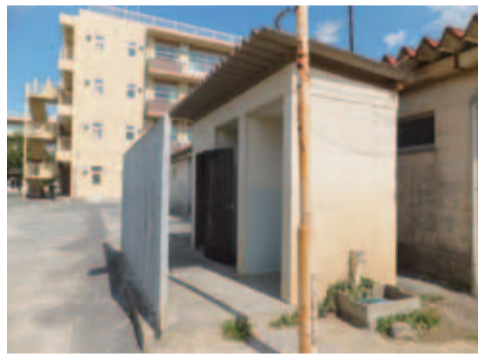
多目的トイレへの改修が望まれる小中学校の屋外トイレ
