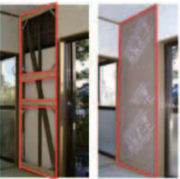
■補正9号 耐震改修工事(補強枠と耐震ボードの設置)の様子
