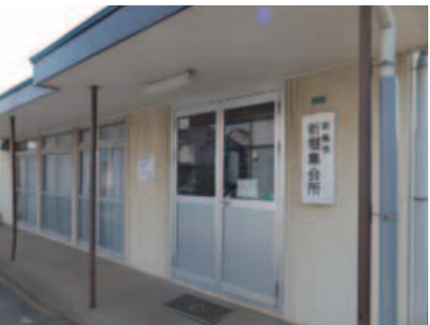
建替えの要望をされた新堀集会所
