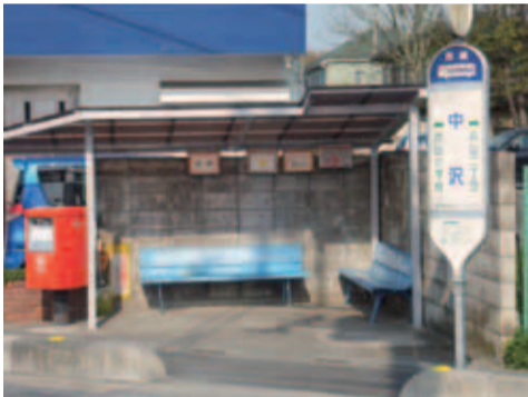
屋根の修繕等の対応が図られた中沢バス停留所
