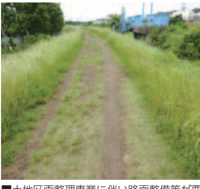
土地区画整理事業に伴い路面整備等が要望される柳瀬川周辺
