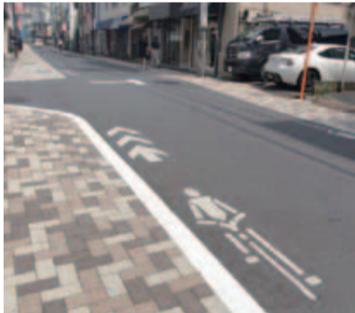
路面に設置された自転車ナビマーク(代々木上原駅周辺)
