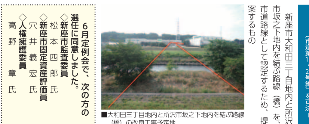
■大和田三丁目地内と所沢市坂之下地内を結ぶ路線(橋)の改良工事予定地
