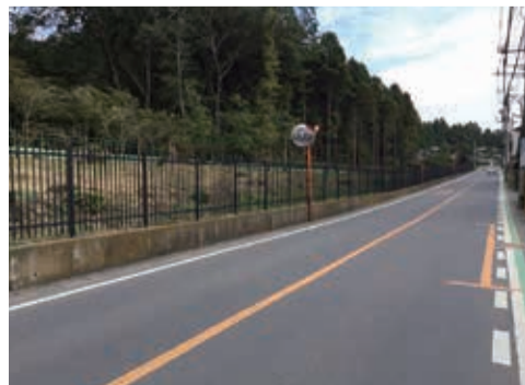
■散策道の整備が予定されている平林寺境内(伊豆殿橋～黒門)
