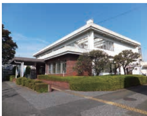
移転等の検討がされている市役所第三庁舎
