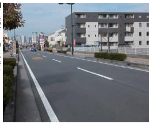
新座駅南口通線の様子
