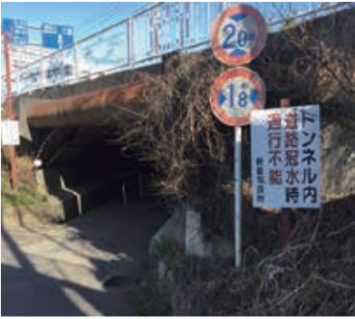
市内に設置済みの「道路冠水時通行不能」看板
