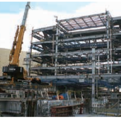
工事が進む市役所新庁舎の工事現場
