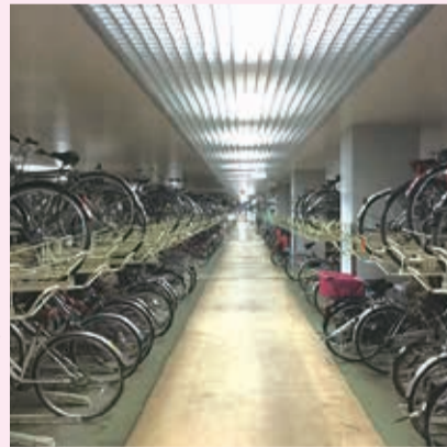
ESCO事業を活用して照明がLED化される新座駅南口地下自転車駐車場
