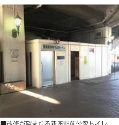
改修が望まれる新座駅前公衆トイレ
