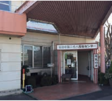
老朽化により移設の要望がある第二老人福祉センター
