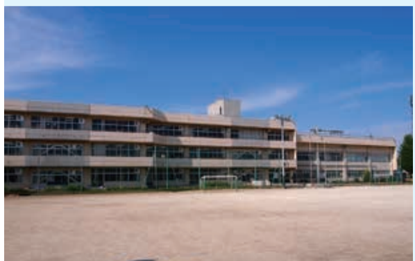
大規模改修工事が行われる石神小学校
