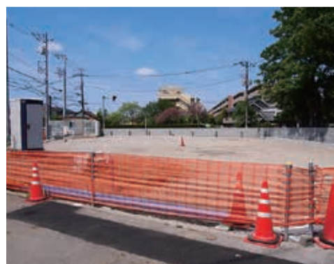
工事中の東一丁目バス待機場予定地
