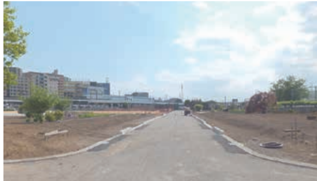
■整備が進む新座駅北口土地区画整理地内
