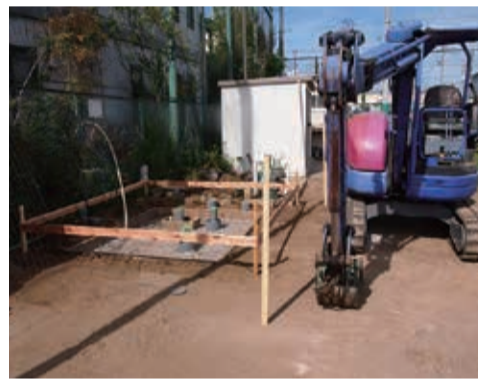
堀ノ内少年運動場に建設中の女子トイレ
