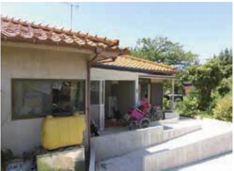
空き家を改修しバリアフリーを取り入れた住まい
