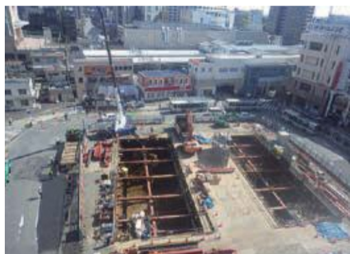
■整備工事の進む志木駅南口駅前広場
