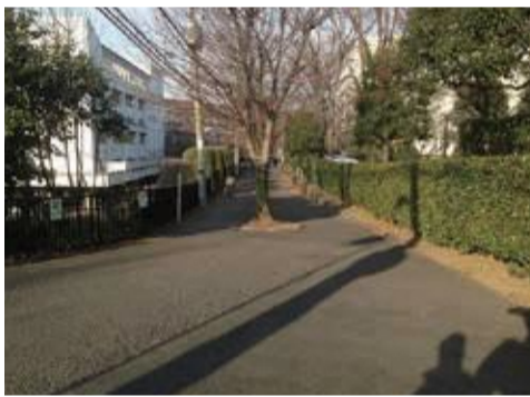
安全対策の要望があった志木市民体育館脇の道路
