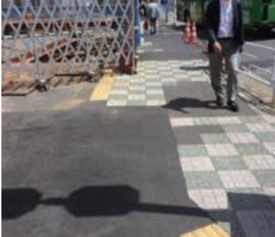
工事用安全柵によって遮られた点字ブロック
