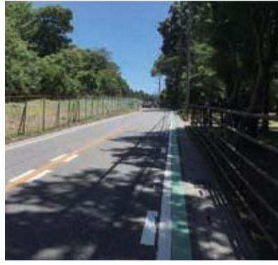
歩道整備予定の陣屋通り
