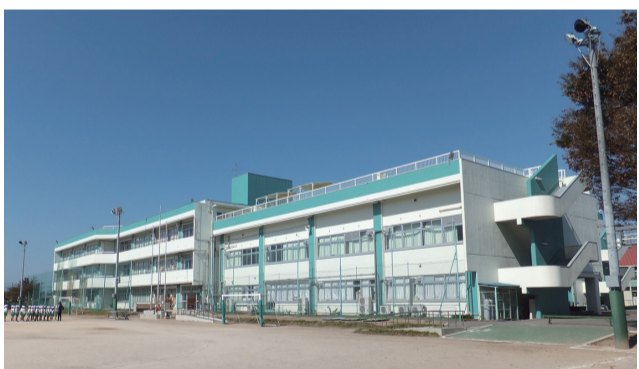
大規模改修が行われた石神小学校
