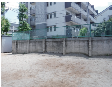
改修予定の東北小学校のブロック塀
