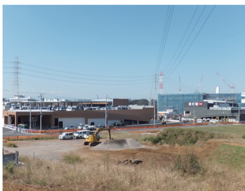
大和田二丁目に建設中の大型店舗
