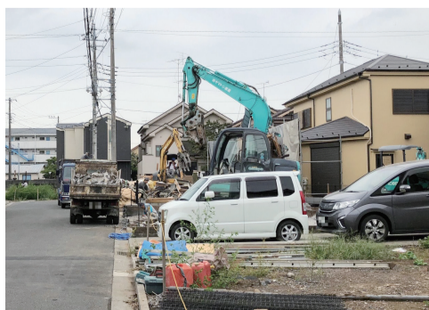
都市計画道路放射7号線工事現場の様子
