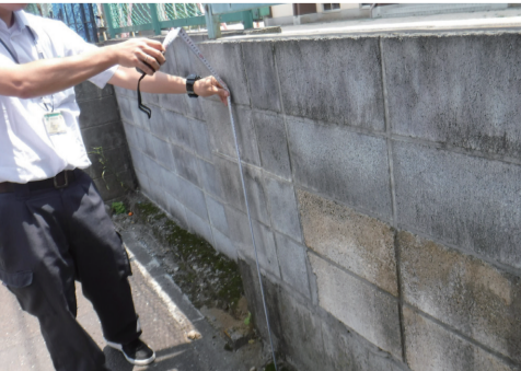
職員によるブロック塀の安全基準の点検
