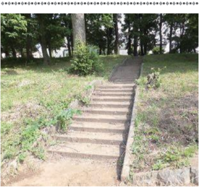
■手すりの設置要望がある野寺緑地内の階段
