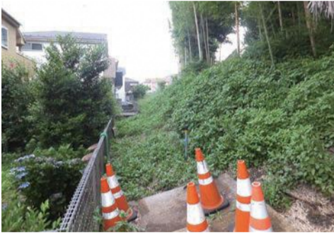
■暗渠管等の設置工事が予定されている大和田五丁目7番地内の市有水路
