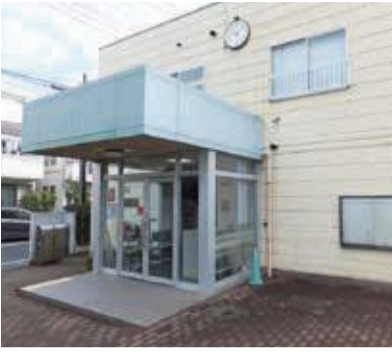
エレベーターの設置要望がある東ふれあいの家
