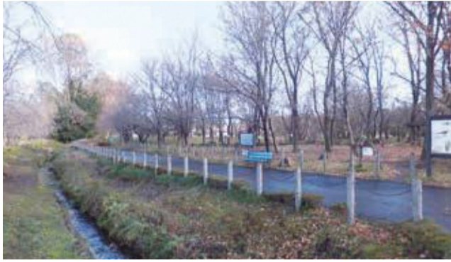
■台風による倒木被害があった野火止緑地総合公園
