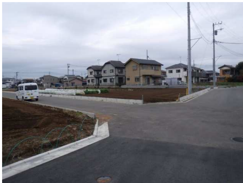
大和田一丁目9番付近に築造された 区画道路6-2及び6-4号線
