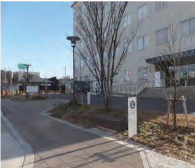
点字ブロックの設置が望まれるタクシー乗場と第二庁舎入口までの動線
