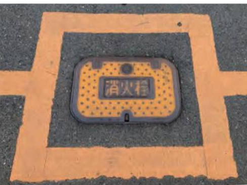
市内に設置してある公共の消火栓
