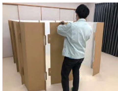
段ボールパーティション組立ての様子
