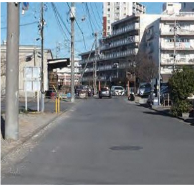
■安全対策が望まれる市道第4059号線
