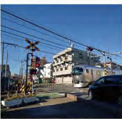
緊急輸送道路上にある踏切
