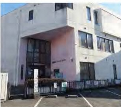
複合施設建設予定地にある東北コミュニティセンター
