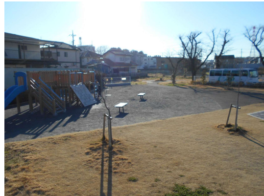
令和元年度に整備した「複合遊具広場」等
