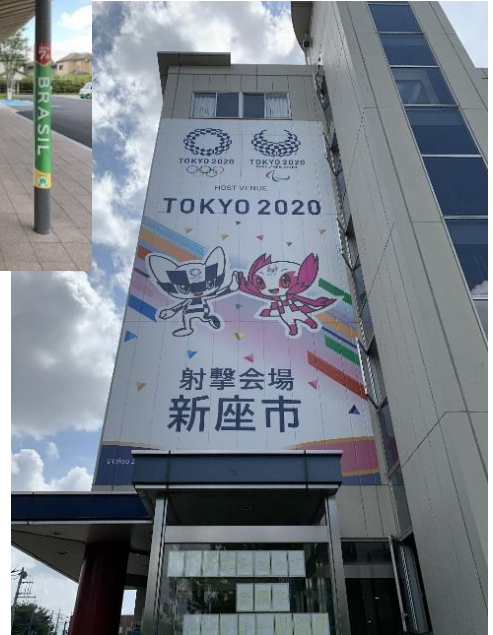
▲第二庁舎壁面
