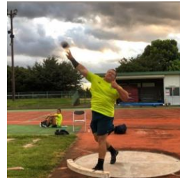
◀ 投てきサークル改修 (陸上競技場) ※写真はブラジル選手が 練習で使用した様子
