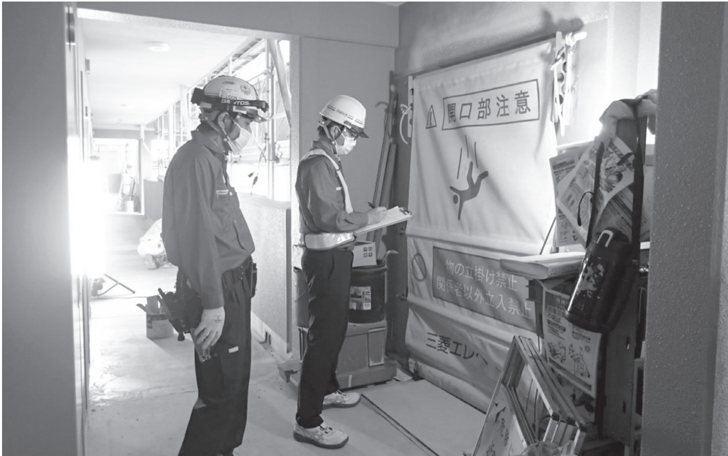
安全パトロールの様子
