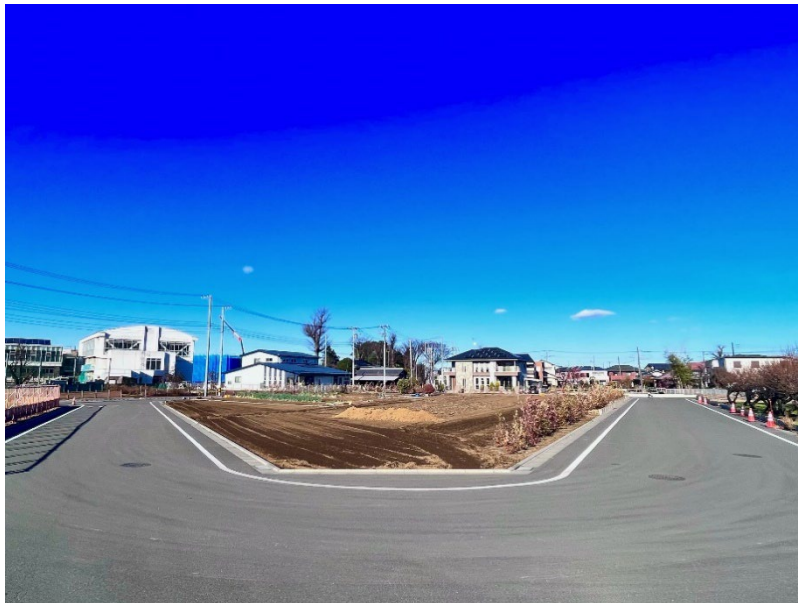
新座駅北口地区内で施工済みの区画道路 区8-7及び8-8号線
