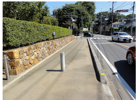
歩道段差の切り下げ(陣屋通り)
