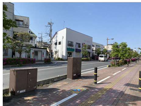
道路の無電柱化((都)ひばりヶ丘片山線)
