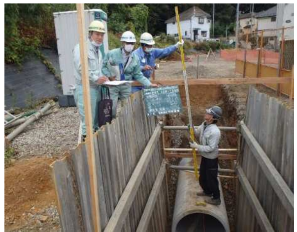
工事現場立会いの様子(開削工法)
