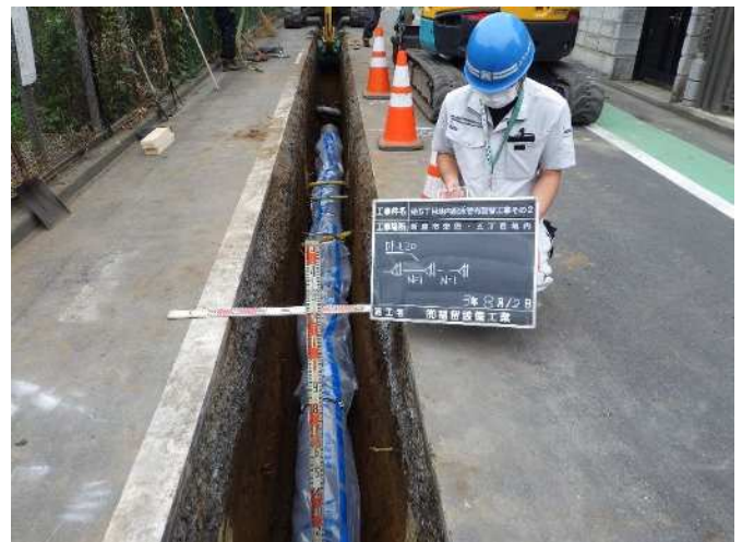
配水管布設替工事の様子
