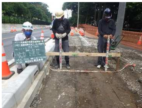
道路工事現場立合いの様子
