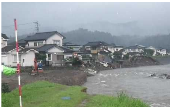
河岸侵食による家屋の倒壊(花月川)
