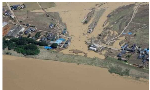
堤防決壊による家屋の流失(鬼怒川)
