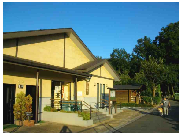
図 5-2 野火止用水周辺の景観に配慮した集会所
