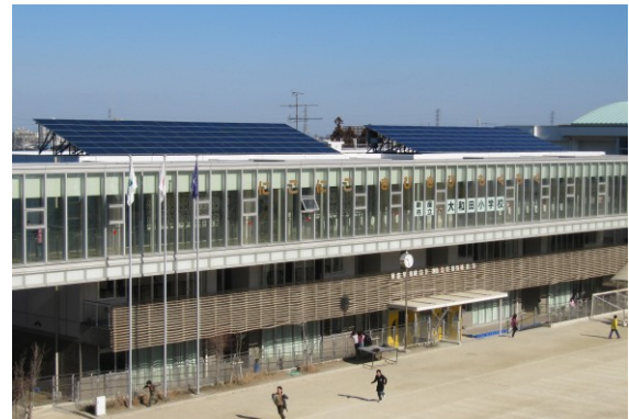
大和田小学校に設置した太陽光発電システム
